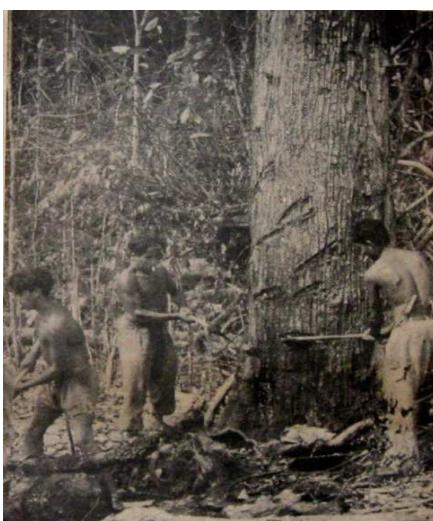
Figura 7 – Na construção da Rodovia Belém-Brasília, a Floresta Amazônica é rasgada a machado. Fonte: RODOVIA Belém-Brasília. Cadernos Belém Brasília 2. Superintendência do Plano de Valorização da Amazônia – SPEVEA. Rio de Janeiro. 1959. p. 08.
